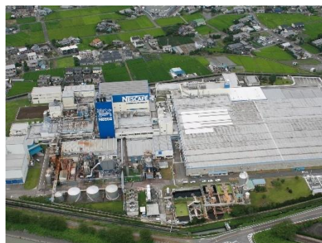
島田工場(静岡県)
